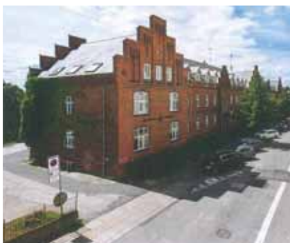
Eksisterende vejadgang via Søren Møllers Gade
