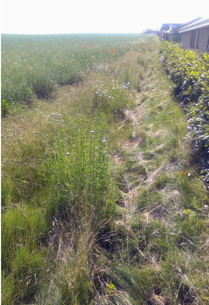
Eksempel på vildsom regnvandsrende mod det åbne land. Trekroner.
