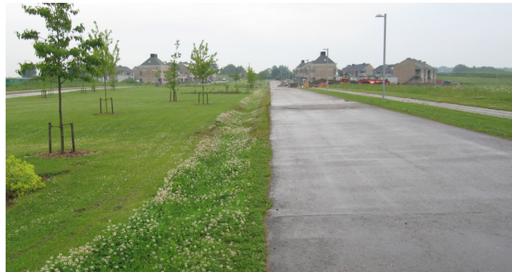
Figur 5: Cverfladevand ledes væk fra kørebane i åben regnvandsrende med vildsom beplantning.
