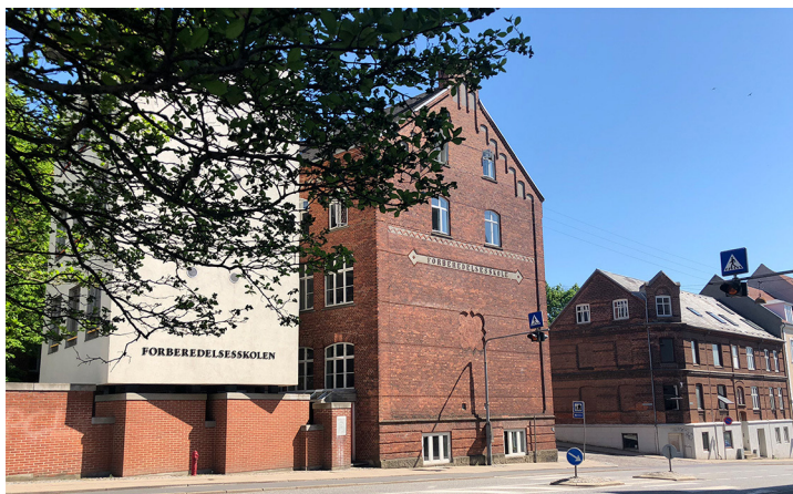
Forberedelsesskolen, eksisterende bygninger Hobrovej 26A
