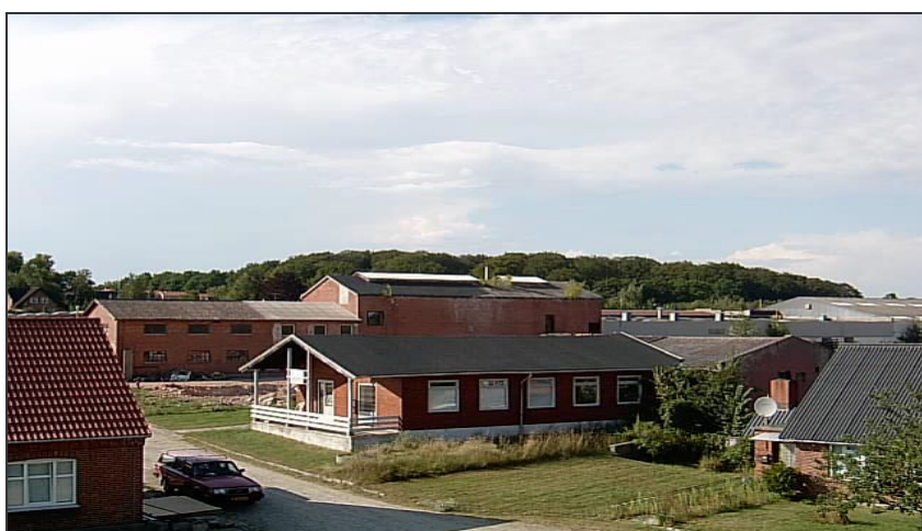
Museet ses som den midterste bygning i billedet og er beliggende i den syd-østlige ende af lokalplanområdet.
