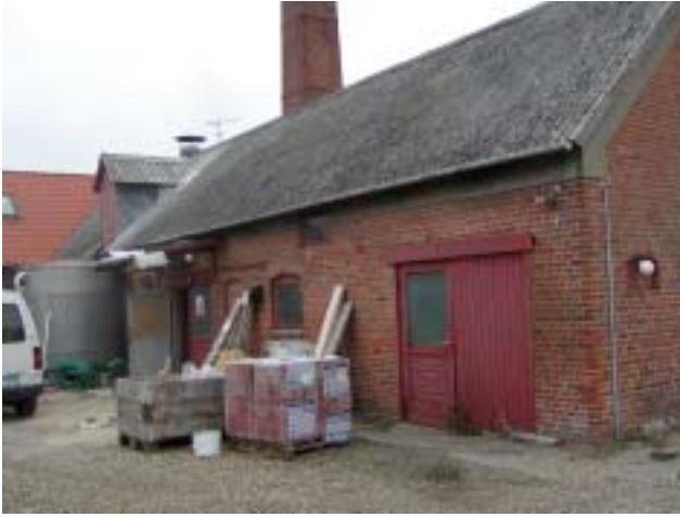
Eksisterende bagbygning/tidligere bageribygning
