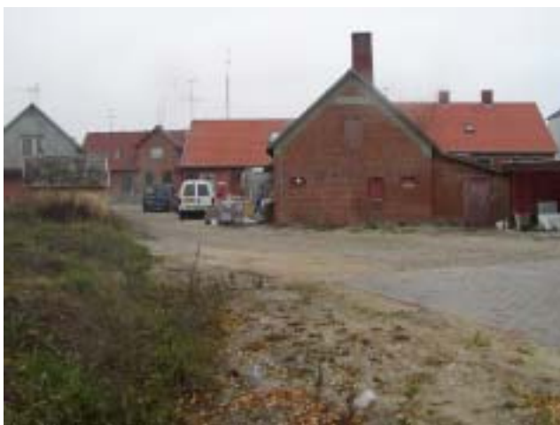
Gavl eksisterende bageribygning
