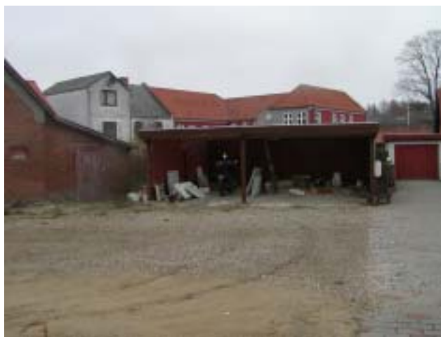
Eksisterende carporte – naboskel mod Storegade 15 B
