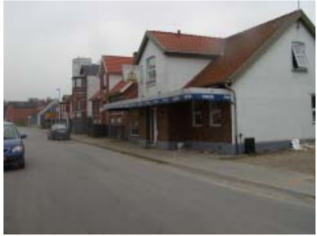
Storegade – eksisterende forhold
