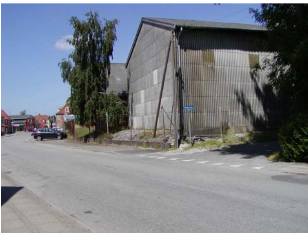
Hjørnet Stadion Allè og Mælkevej.
