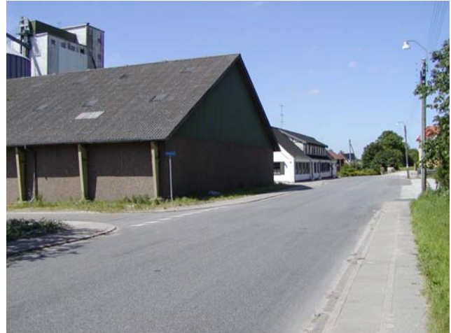
Sigt langs Jernbanegade mod Mælkevej, Fårup Kro og de eksisterende erhvervsbygninger på lokalplanområdet.
