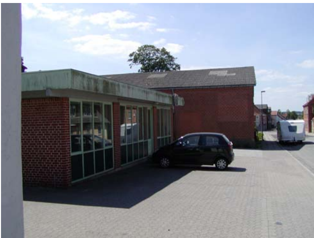
Sigt langs Storegade mod eksisterende erhvervsbygninger på matr.nr. 7 b.
