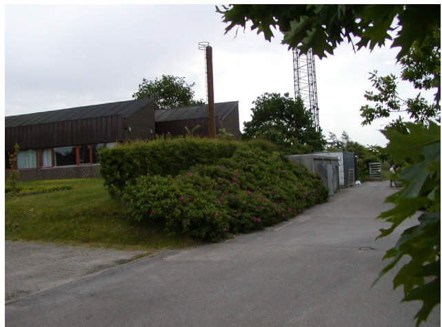
Sigt ved den vestlige indkørsel mod fyrrum, garage og teknikcontainer til antennemast.
