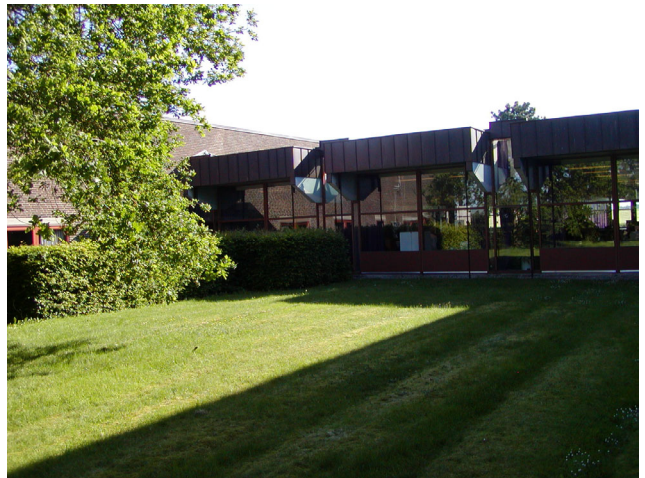
Sigt mod bygningens nordligste storrumsbygning med flad tagkonstruktion og gårdhavemiljø.
