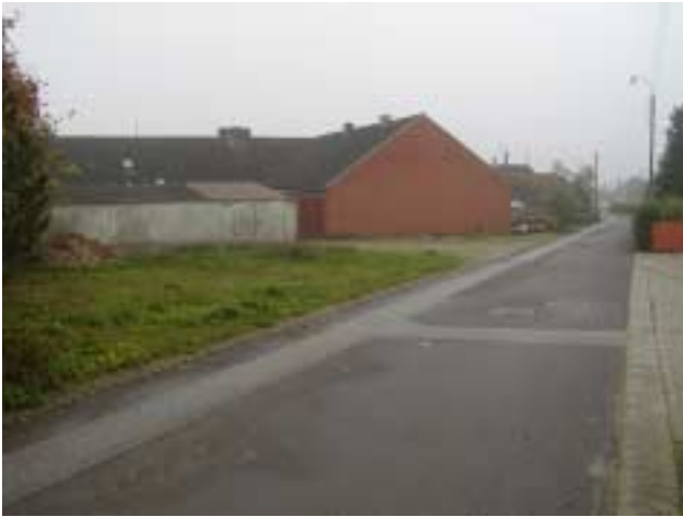
Spentrup Kro (set fra Syrenvej, facade mod nordvest)
