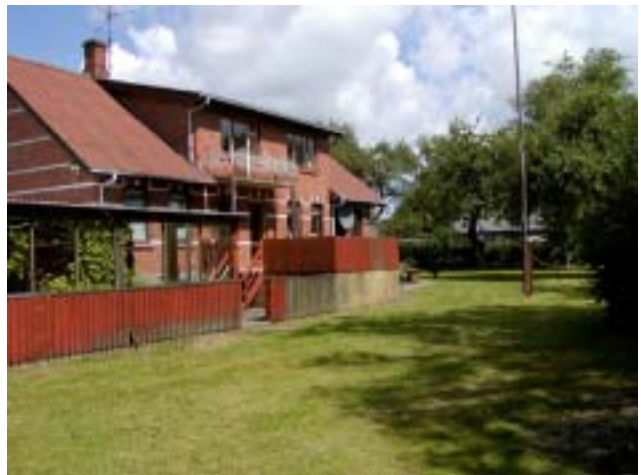
Eksisterende beboelsesbygning – fra haveside
