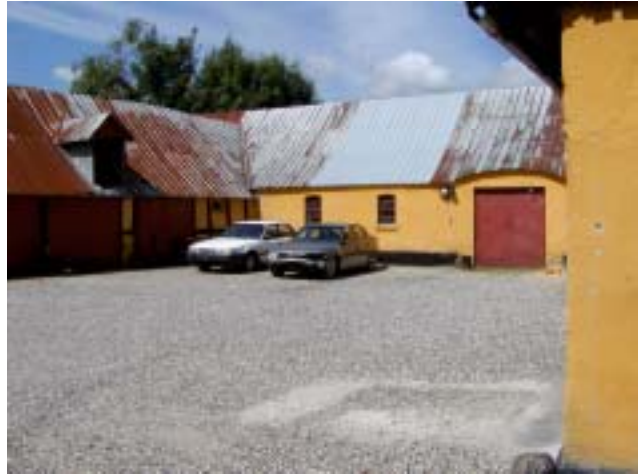
Eksisterende gårdsplads med udhusbygninger
