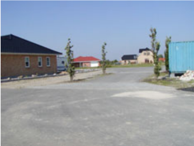
Vejindsnævring Stamvej/boligvej i Højvangen (eksempel)
