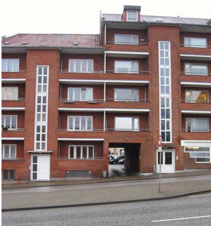
Kvarteret afgrænses mod Vesterterov af den gennemarbejdede bebyggelse fra 1940, der optager det skrånende terræn fint i facadekompositionen.
