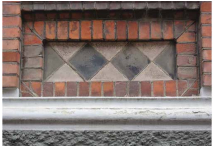
Terracottadetaljer og fint udførte fuger, samt et fint trukket pro fileret gesimsbånd, der danner overgang til den rustikerede sokkel.
