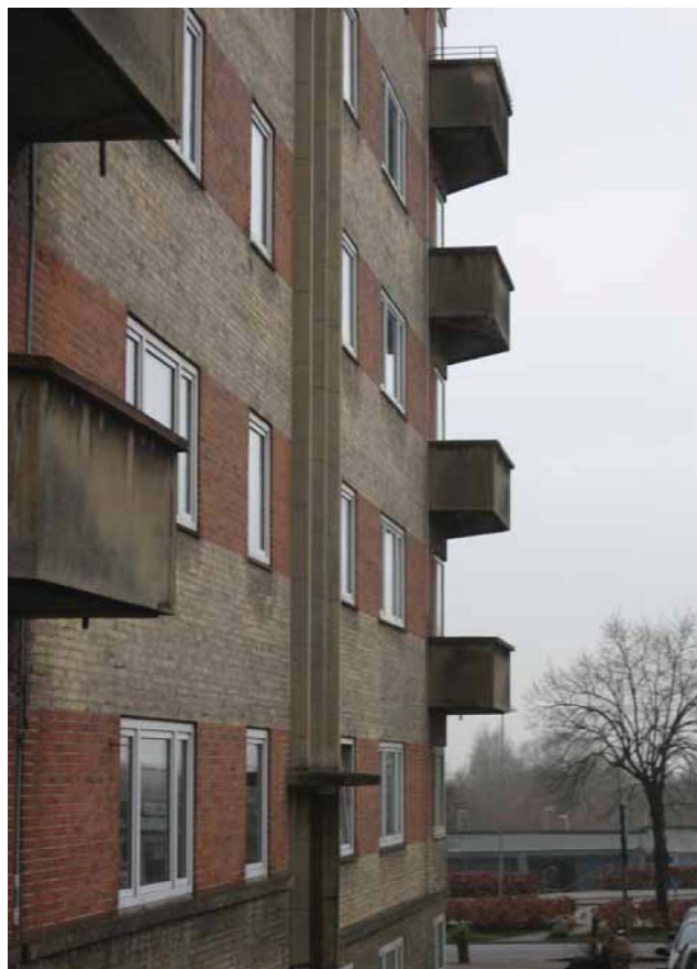
Hobrovej 42 "Fritsvævende" altaner med støbte brystninger.
