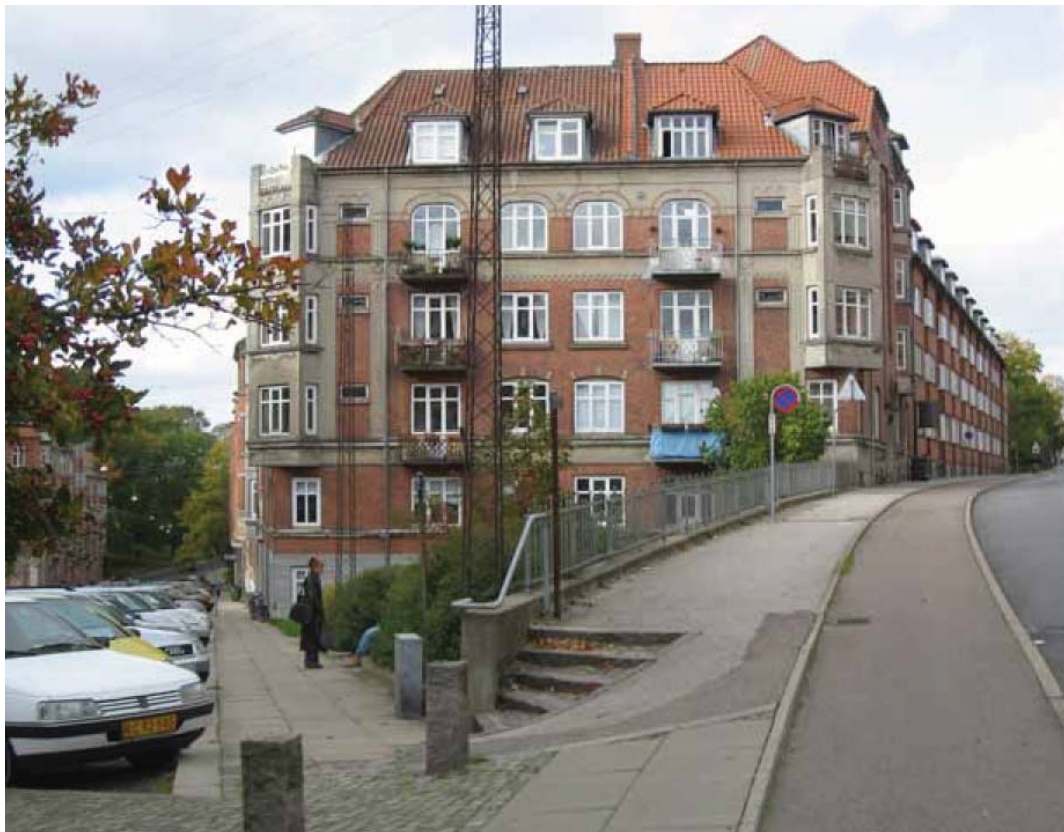
Hjørneejendom mellem Hobrovej og Prins Christians Gade opført 1914 med de for området typiske karnapper og altaner. Bygningen optager elegant niveauforskellen på en hel etage mellem de to gader.
