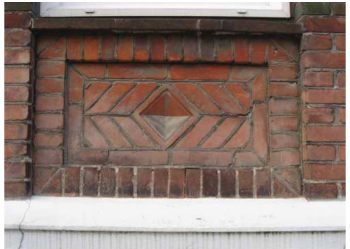
Mønstermurværk i kombination med formsten i terracotta i vinduesbrystning.
