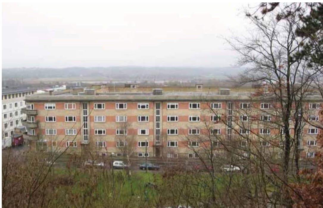
Vesterport Det flade tage skulle ifølge arkitektens vision benyttes til ophold og legeplads.
