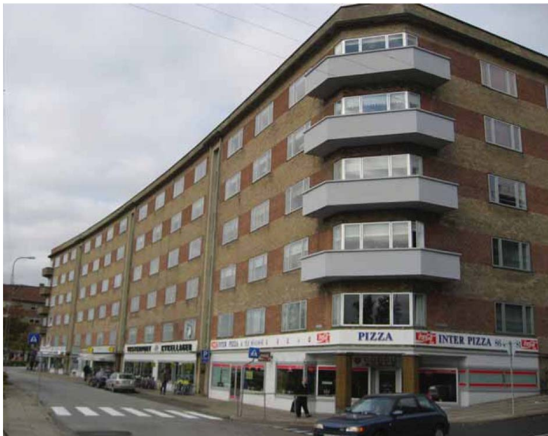
Vesterport tegnet af arkitekt Hjersing i 1932. Bygningen, der fylder hele karréen ud, er typisk for perioden med den vandrette inddeling af murværket og de lodrette partier, der markerer de indvendige trapper.
