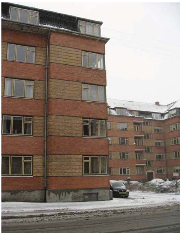
Hobrovej 38 - opført 1939 Vandret inddeling i murværket og de for perioden typiske hjørnevinduer.
