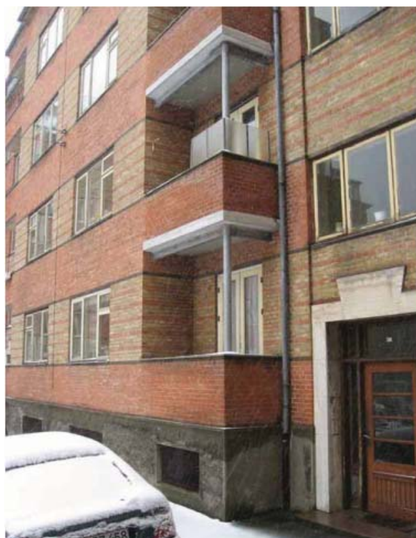
Hobrovej 38 - opført 1939 Vandrette bånd i røde og sorte tegl og indgangsdør indfattet i travertin. Over døren er de oprindelige tofarvede vinduer bevaret.
