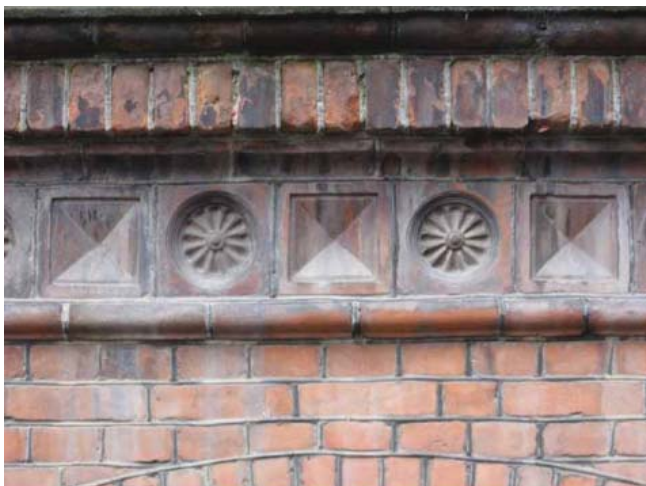
Gadehusene i Vester Altan prydes af smukt udført murerarbejde med rigelig brug af formsten.
