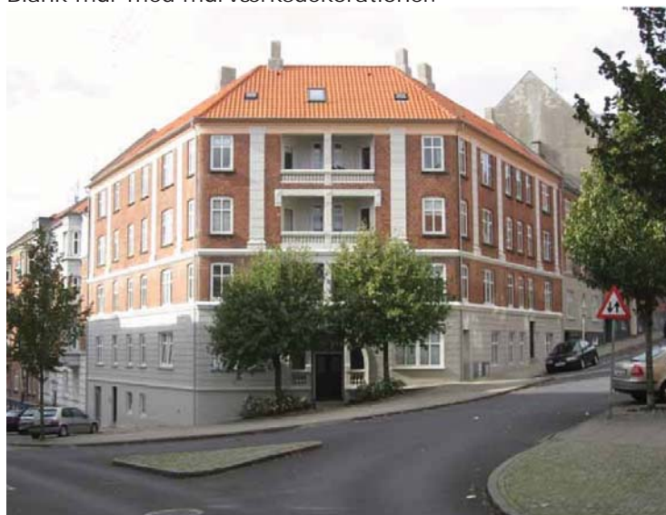
Hjørneejendom i Pontoppidansgade/Danmarksgade opført 1911 med facader i blank mur med refendfuget underetage og tilbagetrukne altaner med støbte balustre.
