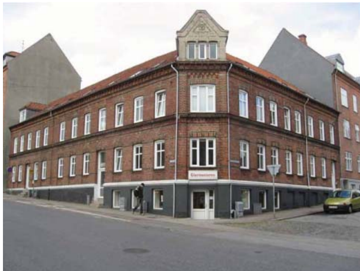
Vester Altan-kvarteret kendetegnes af enkle gadehuse opført i rødt murværk med formsten og glaserede tegl. Facaden har regelmæssigt placerede vinduer og døre, gennemgående vandrette gesimsbånd og pudset sokkel med profileret afslutning. Hjørnejendommene er næsten uden undtagelse udført med en særlig markering, enten med skrå afskæring eller med markant hjørnetårn eller spir. Her hjørnejendom på St. Blichersgade/Hobrovej.
