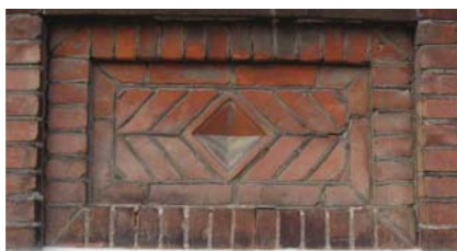
Gadehusene i Vester Altan prydes af smukt udført murerarbejde med rigelig brug af formsten.
