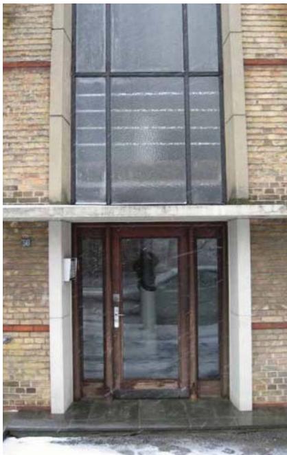
Hobrovej - opført 1939 Vandrette bånd i røde tegl, fordakning over den helrude dør og gennemgående trappevindue.
