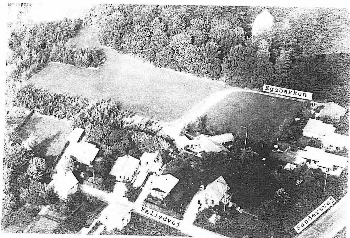
Luftfoto af lokalplanområdet set fra syd.
