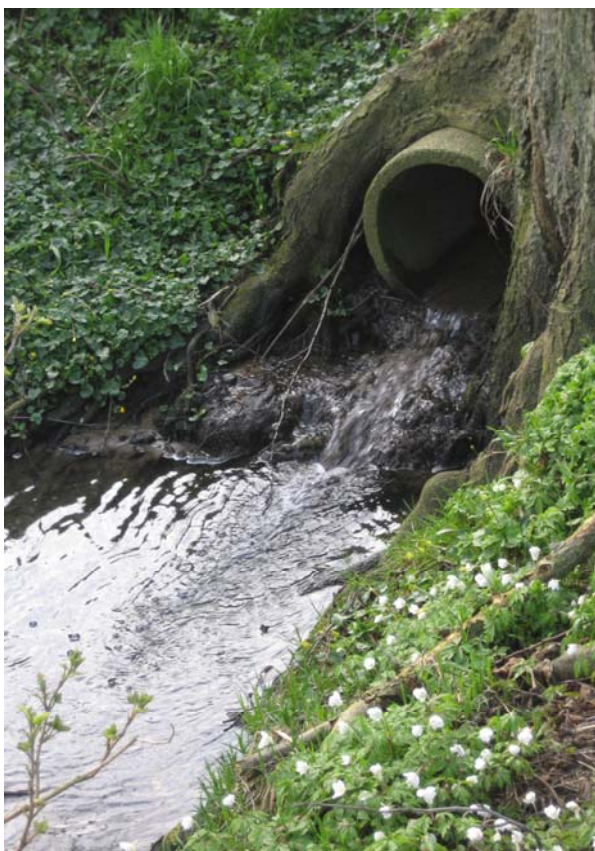
Kloakudløb i vandløb ved Laksevej i Langå.
