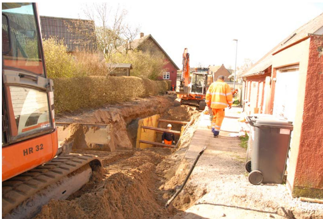
Kloakfornyelse i Råby.
