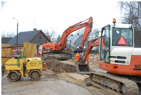
Kloakarbejder i Råby.
