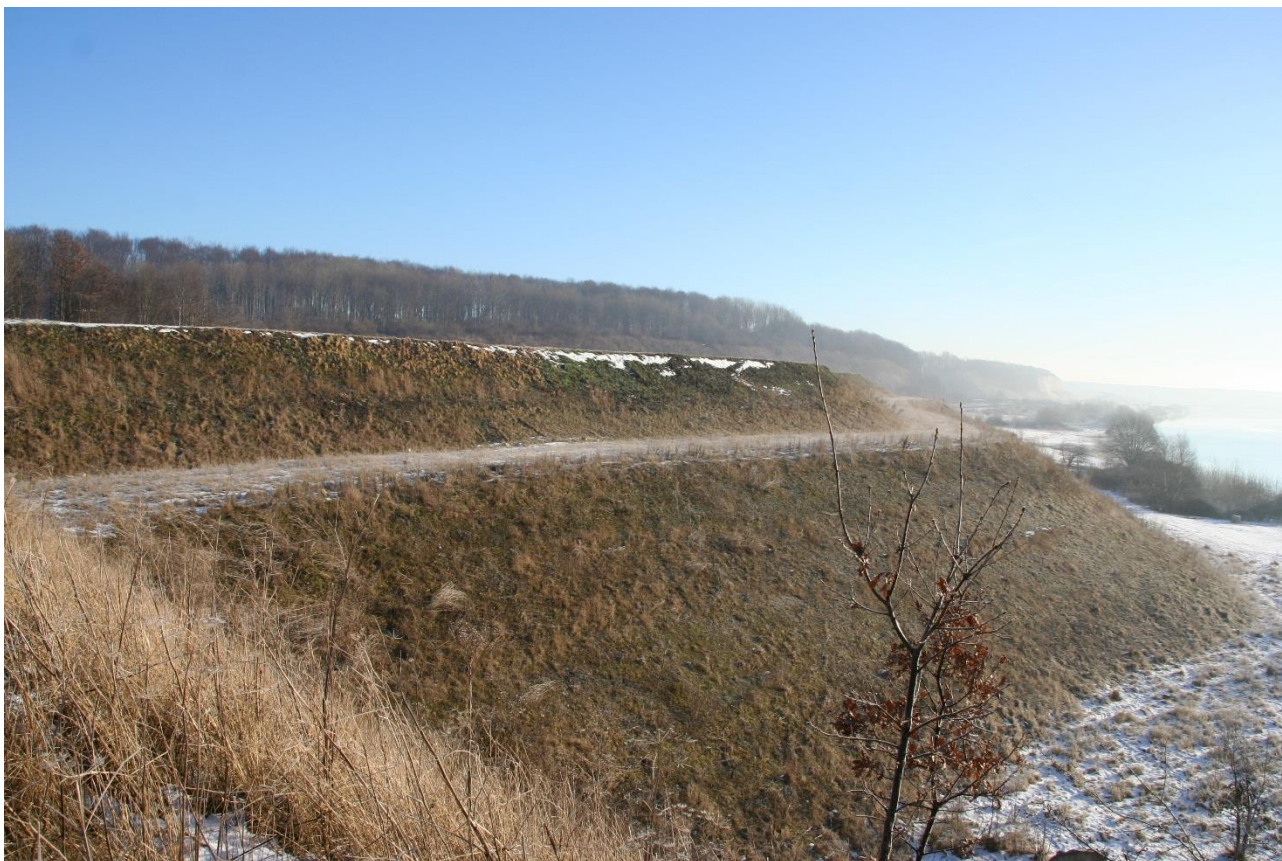
Figur 10. Etablering af Etage 2. Februar 2017.
