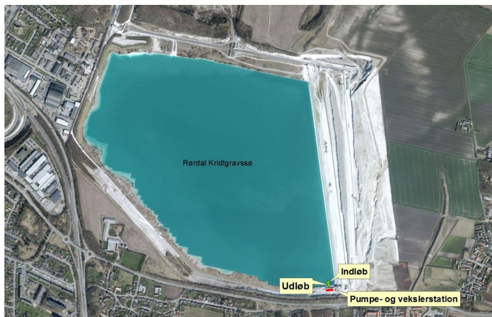
Figur 11: Luftfoto af Rørdals Kridtgravssø hvorfra der indvindes vand til fjernkøling. Området med placering af pumpe- og vekslerstation er markeret med rød firkant og der er markeret indtag og udløb af fjernkølingsvandet i søen.
