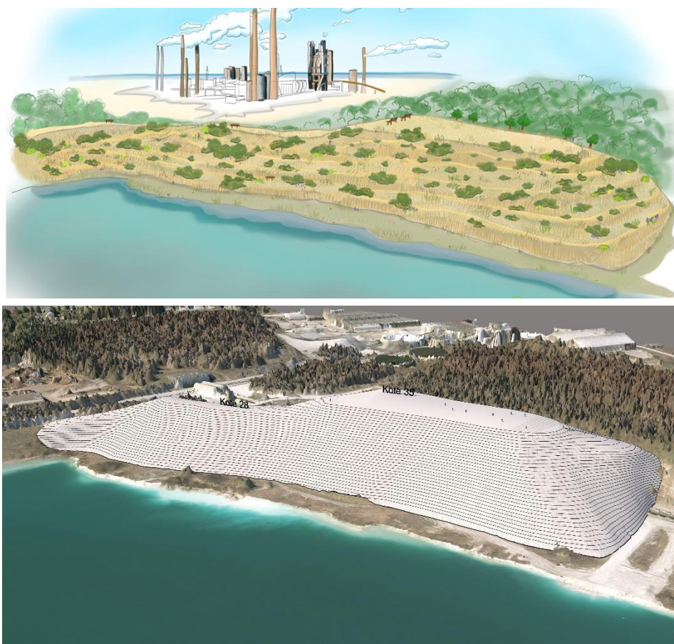
Figur 2.3 Illustration af den fremtidige udformning af NGA 1 udført hhv. optegnet og i 3d-modelleringsprogram.
