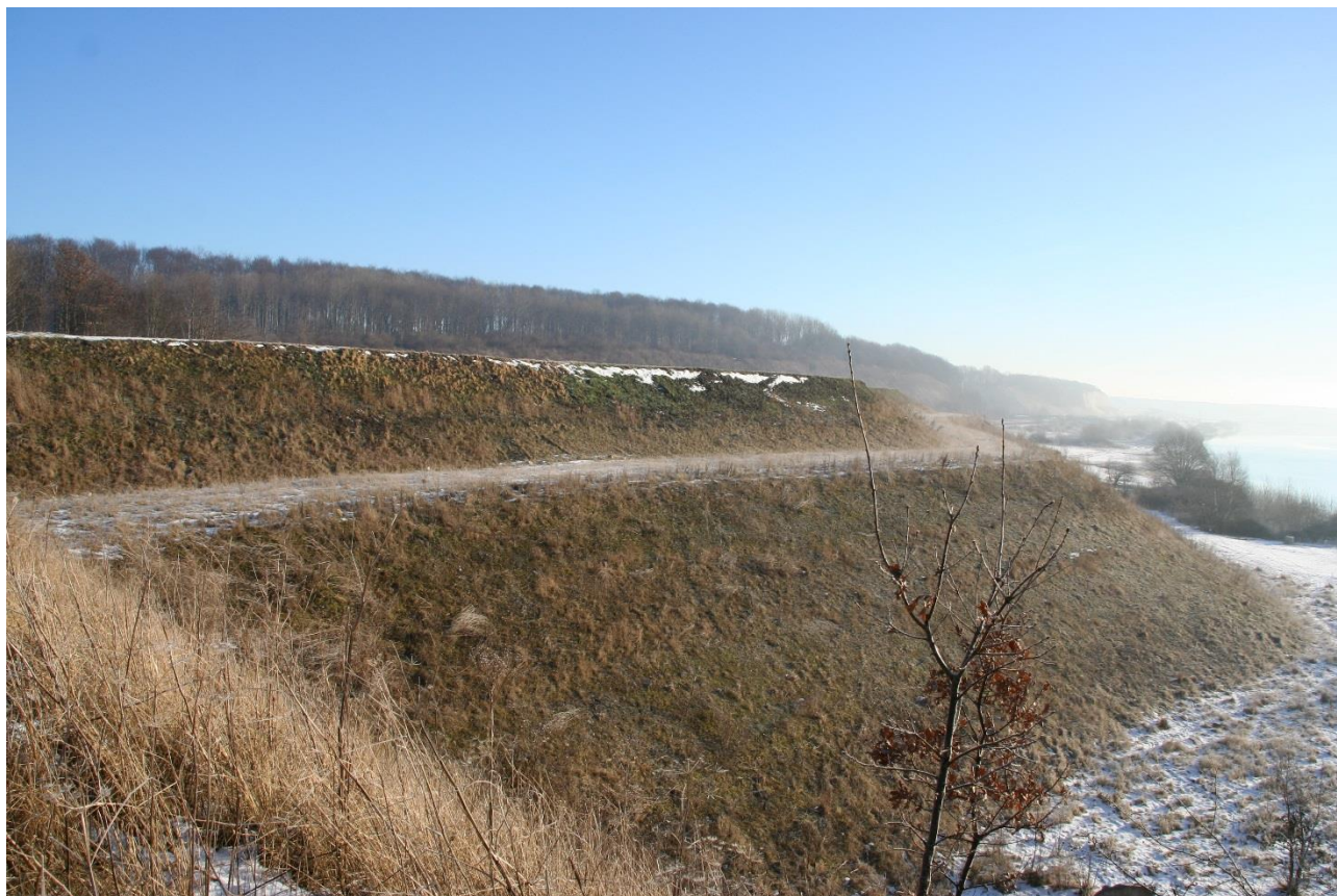
Figur 10. Etablering af Etage 2. Februar 2017.
