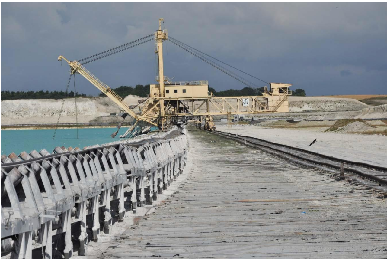
Figur 2. Dybdegraver, der udgraver kridt til en dybde af 40 m under vandspejlet.
