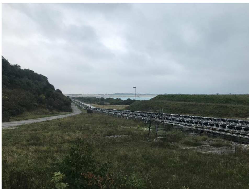
Figur 2.2 Nyttiggørelsesanlæg 1 i højre side af billedet og den tidligere gravefront i venstre side af billedet. Billedet er taget nord for NGA 1 og i østlig retning langs transportbåndet.
