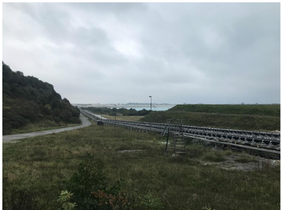
Figur 2.2 Nyttiggørelsesanlæg 1 i højre side af billedet og den tidligere gravefront i venstre side af billedet. Billedet er taget nord for NGA 1 og i østlig retning langs transportbåndet.
