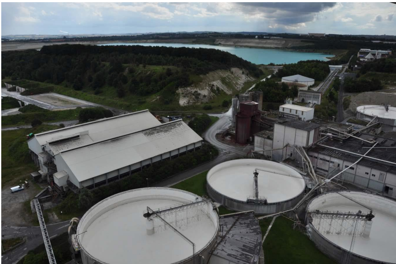
Figur 5. Den allerede efterbehandlede del af Kridtgraven ses som de beplantede område i den bagerste højre (nordlige) side af Kridtgraven.
