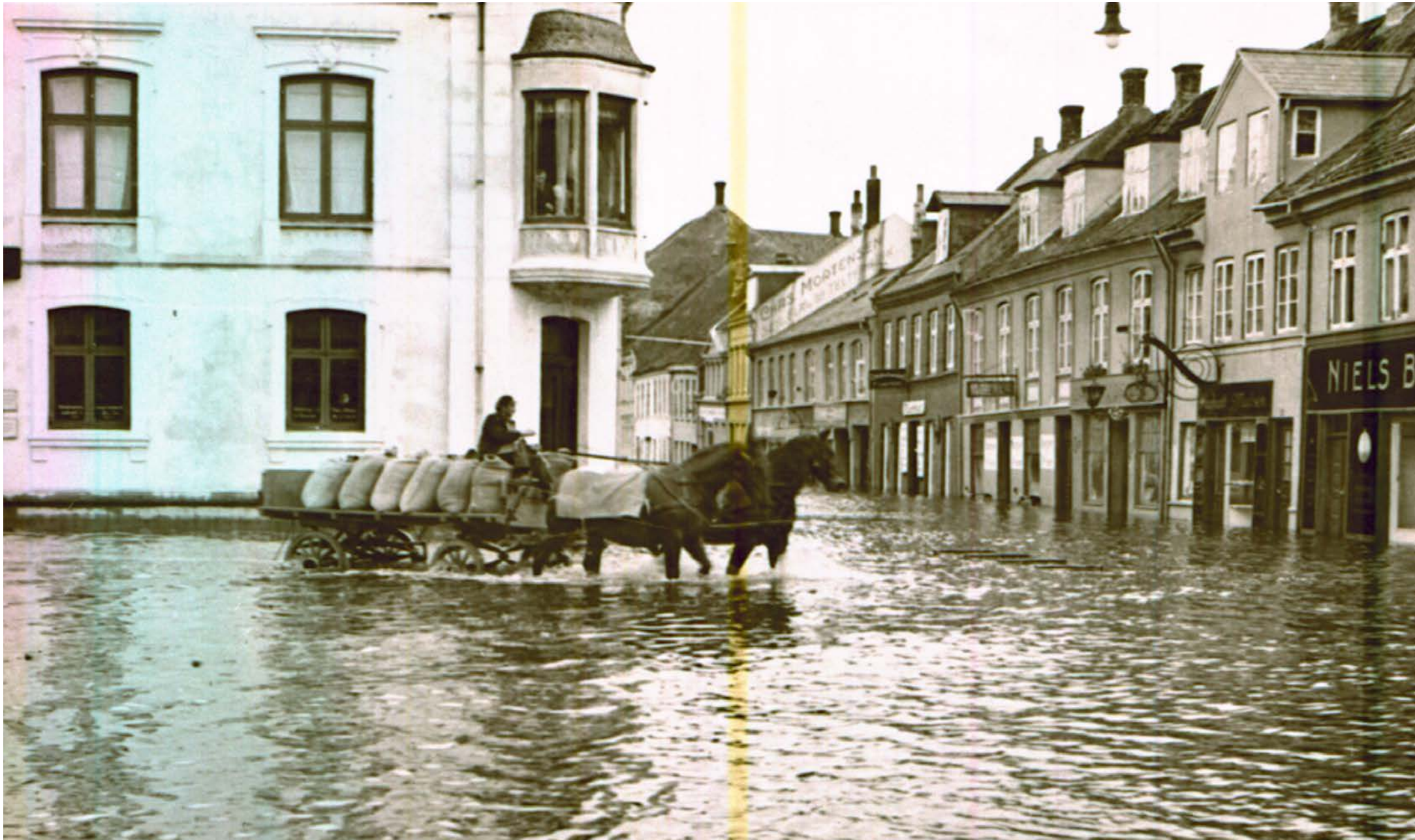
[Oversvømmelse ved Frederiksplads og Carolinegade (nuv. Østervold) 1921. Randers Stadsarkiv]
