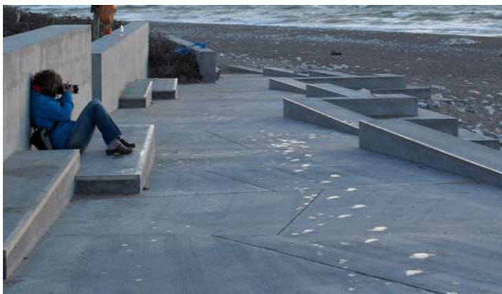
Klimatilpasning_Terrænmur til kt. 3.00 Der etableres en sikringsmur der samtidig er et multifunktionelt møbel der inviterer til ophold, og har integreret paviljoner, trapper og bænke
