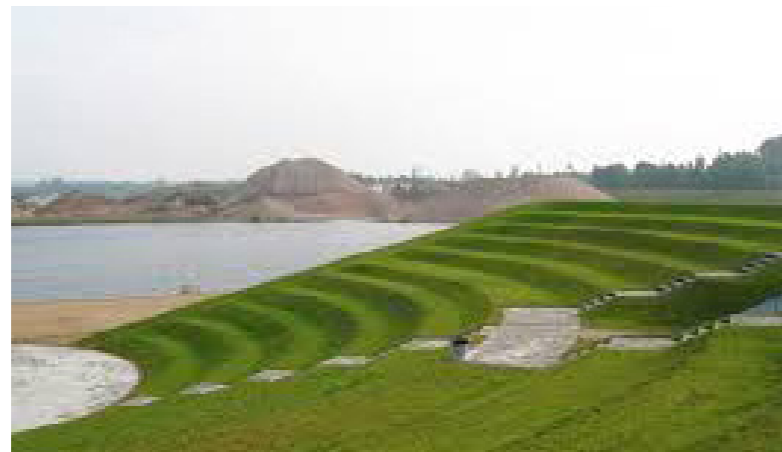
Klimatilpasning_Dige_Bagkanten af Amfien er digeopbygning
