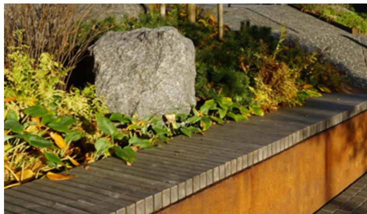
Klimatilpasning_Terrænmur til kt. 3.00 Der etableres en sikringsmur der samtidig er et multifunktionelt møbel der inviterer til ophold, og har integreret paviljoner, trapper og bænke
