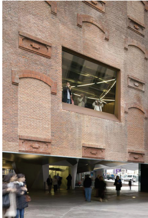
▲ CaixaForum Madrid, Herzog & de Meuron Nye hultagninger for forbedret adgang og udkig/indkig. Bannere på facaden.
